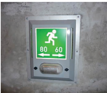
Die Fluchtwegbeschilderung gibt in vielen Fällen nicht nur die Fluchtrichtung, sondern auch die Entfernung zum nächsten Notausgang an
