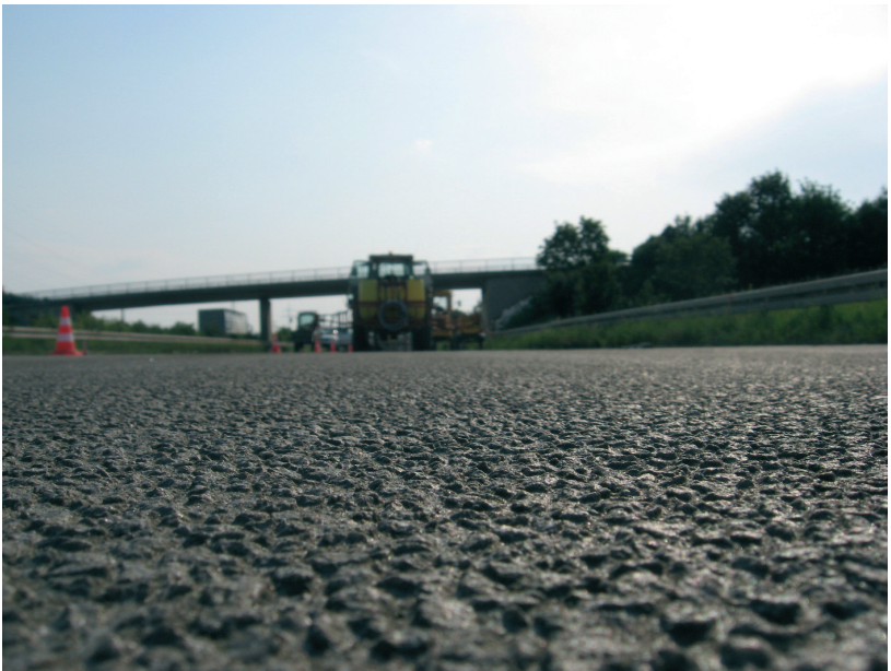
Griffige Waschbeton- oberfläche
